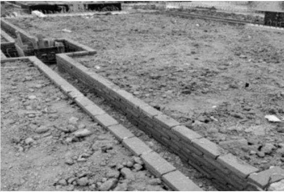
图2 (a) 梁板式架空地坪的砖模板
