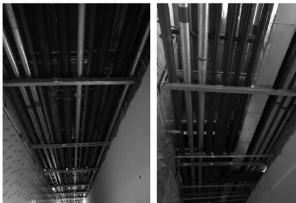
图3 厂房走道内综合支架现场施工图
